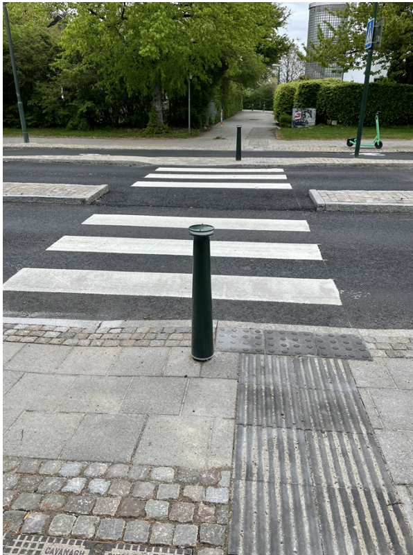
Bild 2. Stadiongatan, färdigbyggt övergångsställe med taktil information.
